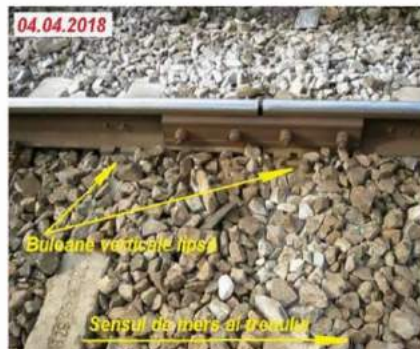
Foto nr.8 – Joanta de capăt a JIL-ului de la semnalul de trecere BL11, de pe firul din stânga al căii
