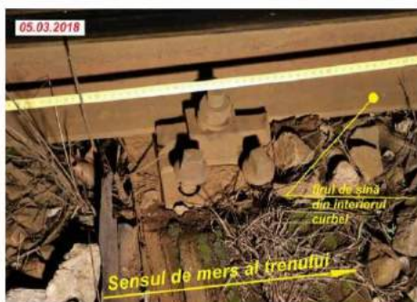
Foto nr.12 – Locul de cădere între firele căii (șina din stânga) – cu tirfoane ce se puteau scoate cu mâna
