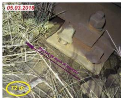
Foto nr.9 – Sarea traversii T2, capătul din dreapta (exteriorul căii)
