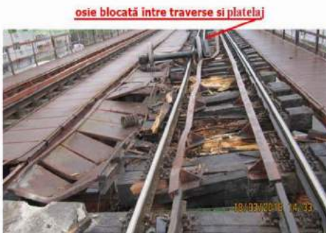
Fig. 6 – podul cu osia ieșită de vagon
