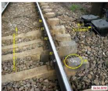
Foto nr.3 – Semnalul luminos de trecere BL 11- poziția km 232+ 910
