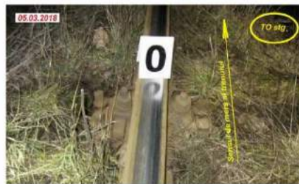
Foto nr.5 – Starea traversei T0, capăt din stânga (interiorul căii)
