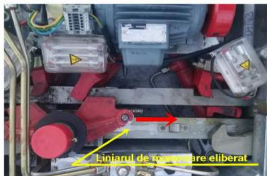
Fig.6 Electromecanismul de acționare a macazului schimbătorului de cale nr.27 – talonat
