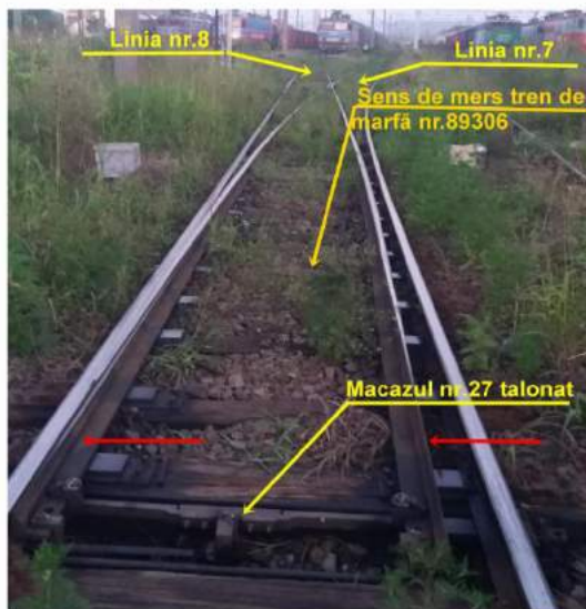
Fig.7 Macazul schimbătorului de cale nr.27 - talonat
