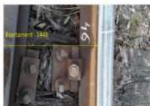
Imaginea nr. 18 - Traversa putredă în dreptul punctelor de măsurare 36, 37, 43, 44, 45, 46
