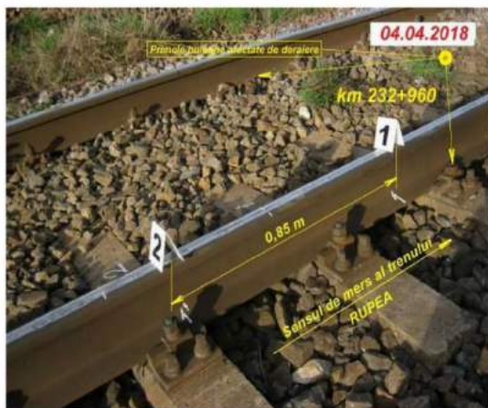
Foto nr.5 – Prima urmă de deraiere lăsată de buza bandajului roții nr.1 din dreapta a primei osii a boghiului 1, la căderea de pe șină.
