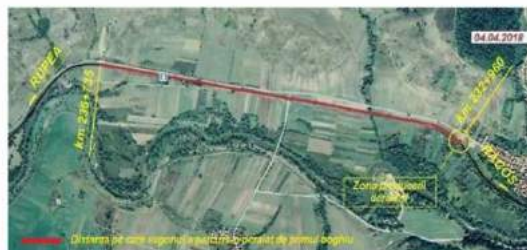
Figura nr.2 – Locul producerii accidentului. Distanța de 63775 m parcursă de vagon în stare deraiată
