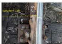
Imaginea nr. 18 - Traversa putredă în dreptul punctelor de măsurare 36, 37, 43, 44, 45, 46
