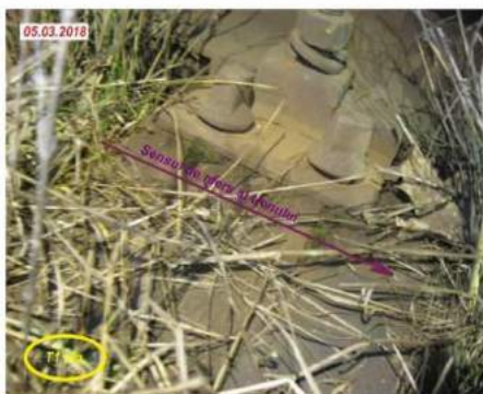
Foto nr.7 – Sarea traversii T1, capătul din stânga (interiorul căii)
