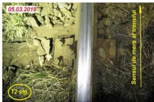
Foto nr.8 – Sarea traversii T2, capătul din stânga (interiorul căii)
