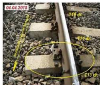
Foto nr.6 – Traversa T13, capăt dreapta, cu placă manevrată la sudură
