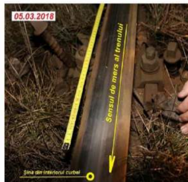
Foto nr.13 – Sarea prinderii (șina din interiorul curbei)
