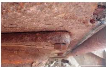
Imaginea nr. 19 - traversa crapodinei superioare deformată (înfundată)
