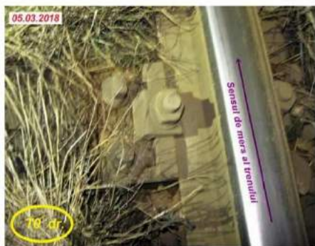
Foto nr.6 – Sarea traversii T0, capătul din dreapta (exteriorul căii)
