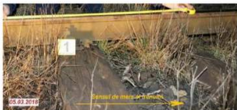
Foto nr.3 - Fața laterală activă a ciupercii șinei de pe firul interior al curbei după deraiere
