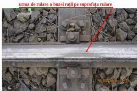
Fig. 5 – urmă de rulare a buzei unei roți pe suprafața superioară al ciupercii șinei
