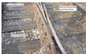
Imaginea nr. 10 Urmelile roților deratate pe aripa dreapta și vârful inimii – punctele 0, E, F
