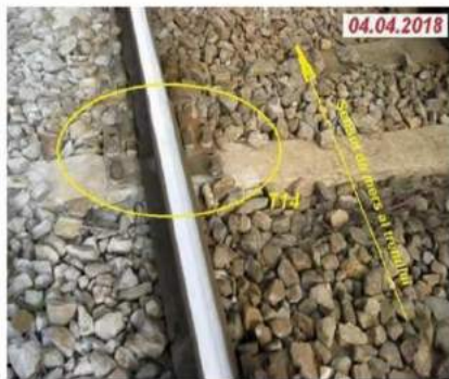
Foto nr.7 – Traversa T14, capăt stânga, cu placă manevrată la sudură
