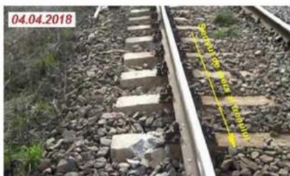
Foto nr.9 – Prisma de piatră spartă incompletă la capătul traverselor, în exteriorul curbei
