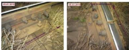
Foto nr.10,11 – Sarea prinderilor la joantele de pe firul stâng interior și firul drept exterior
