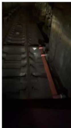
Figura 1. Element al construcției tunelului lovit de ansamblul antirului rupt al semitrenului 1320
