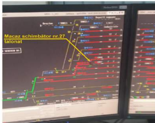
Fig.5 Monitorul instalației de centralizare electronică al stației CFR D.T. Severin după talonare
