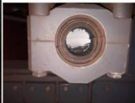
Figura 1. Parte din ansamblul antirului rupt al semitrenului 1320 (capătul de bară rămas fixat în zona articulației de fixare)
