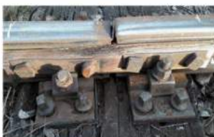
Imaginea nr. 5 Punctul a – joanta de vârf a inimii de încrucișare pe direcția abătută
